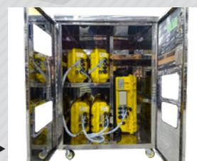
1kWhのバッテリータンクに最大で4基まで増設可能
