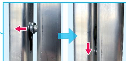
背面手すりの上側に突き出ているフックを横手すりの穴に引っ掛ける。
