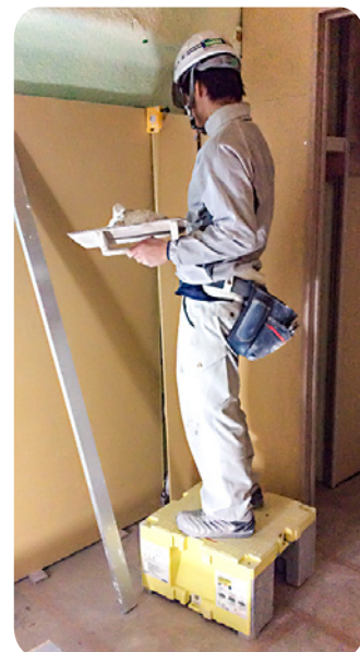
使用イメージ (建設現場)
